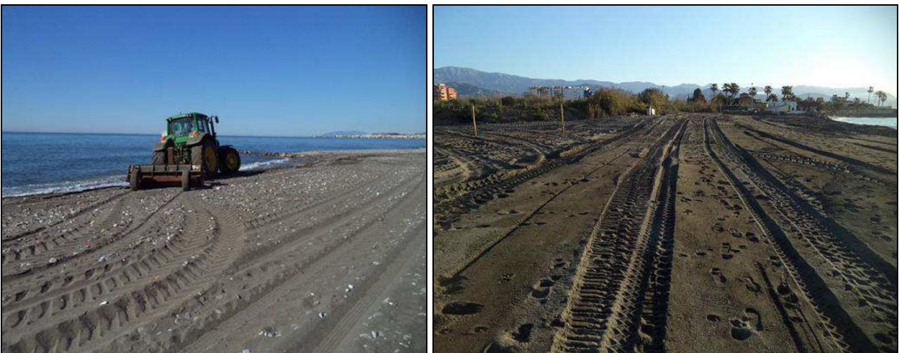
Limpieza mecanizada en una playa y movimientos de tierra para restitución de arena. Imágenes de 2017.
