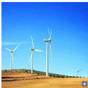
Uno de los parques eólicos de la provincia.
