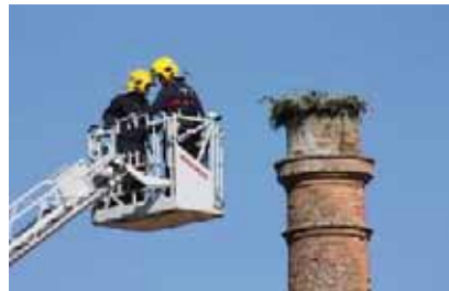
Los bomberos colocaron el nido en la vieja chimenea Blas Gil
