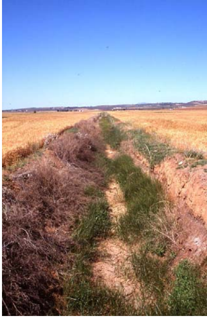
Fotografía 3: Detalle de uno de los canales de drenaje secundario Fot.: Juan José Jiménez
